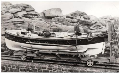
Le canot de sauvetage Félix-William Spiers sur sont chariot de lancement sur la cale de Ploumanac'h , de formes proches des canots d'aviron , il était équipé d'un moteur Baudouin de 10 cv et de deux hélices, à bord le mécanicien Yves Limbourg
